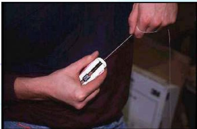
Уклањање секундарне заштите
